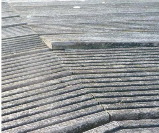
Figuur 4: gedeeltelijk losse plank
