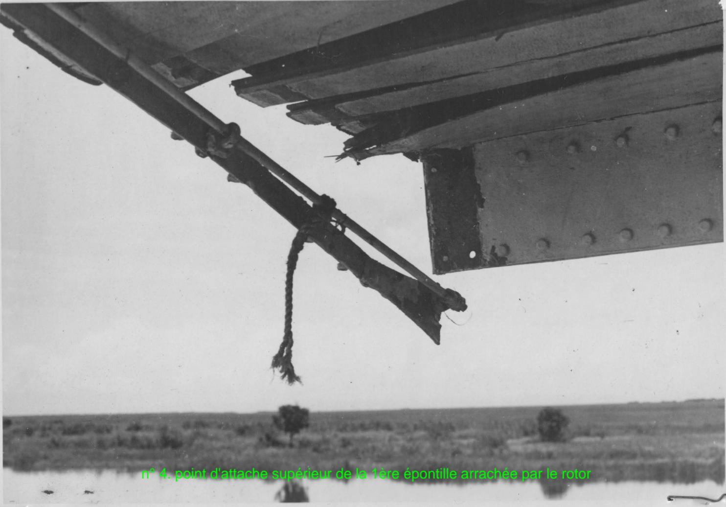
n° 4. point d'attache supérieur de la 1ère épontille arrachée par le rotor
